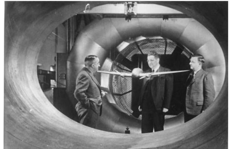
В аэродинамических трубах испытывают небольшие модели, представляющие собой по форме точную копию проверяемого самолёта
