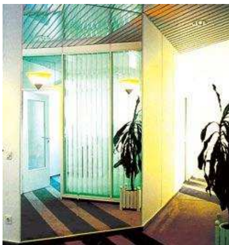
Рис. 50. Перегородка из стеклопрофилита
