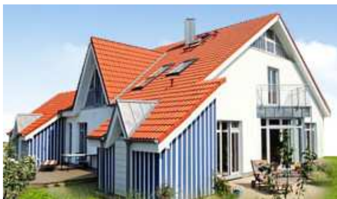
Рис. 96. Неорганизованный водоотвод
