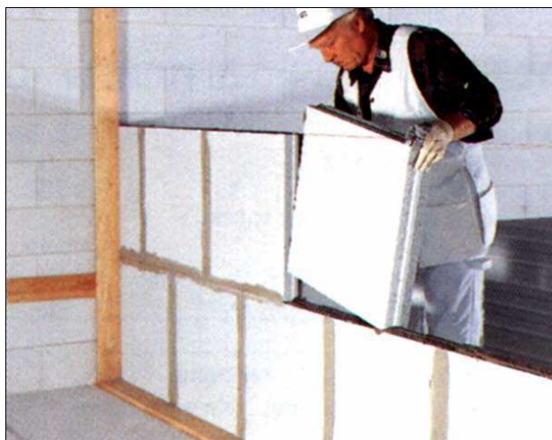
Рис. 49. Перегородка из гипсовых плит
