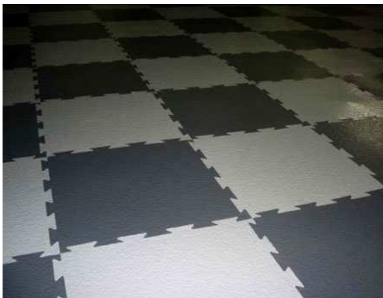
Рис. 69. Полы из поливинилхлоридных плит
