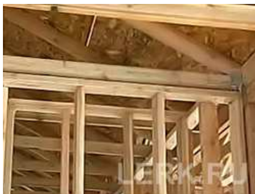
Рис. 53. Конструкция столярной перегородки
