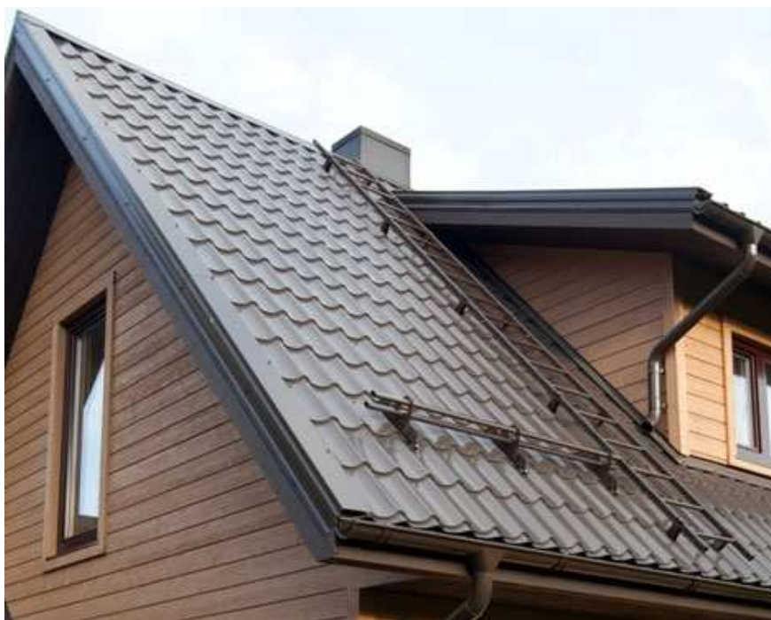
Рис. 109. Кровля из металлочерепицы
