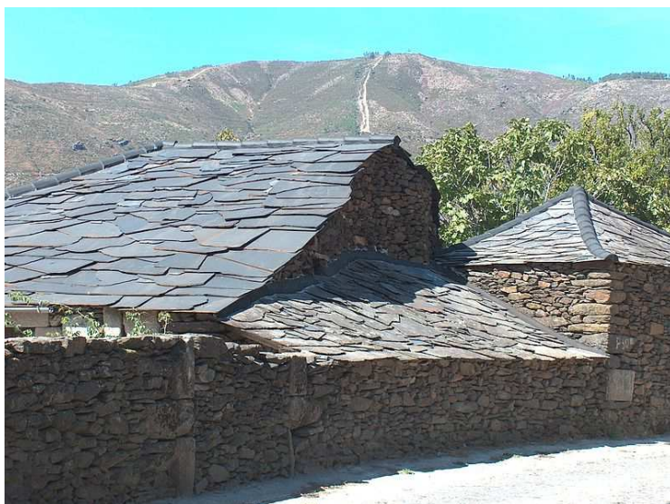
Рис. 103. Вид кровли из природного шифера
