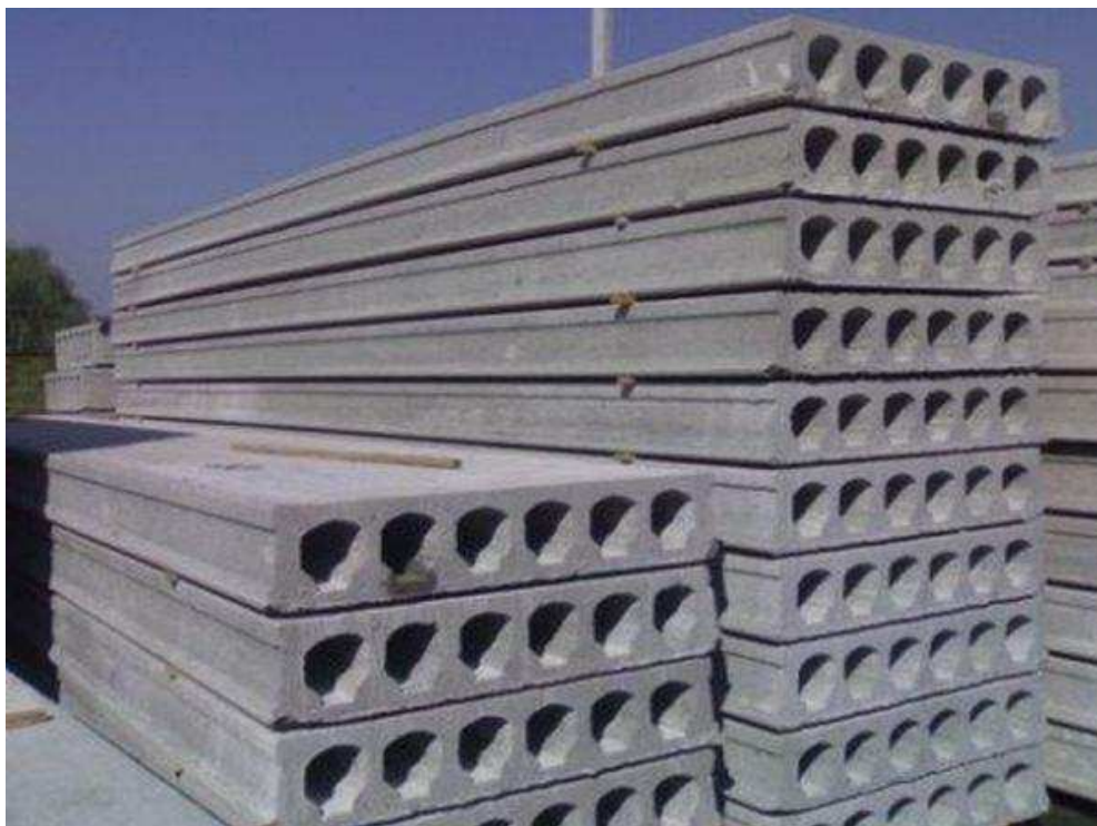
Рис. 60. Складирование железобетонных плит с круглыми пустотами
