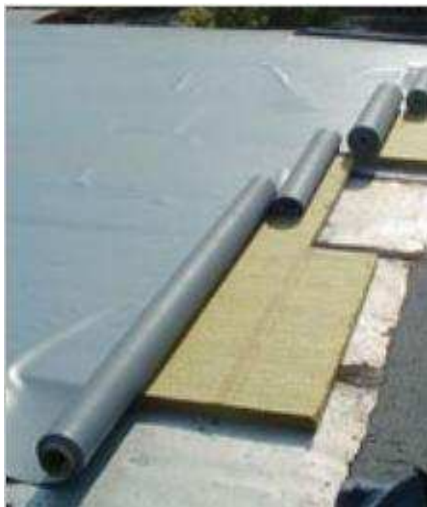
Рис. 110. Кровля из рулонных материалов
