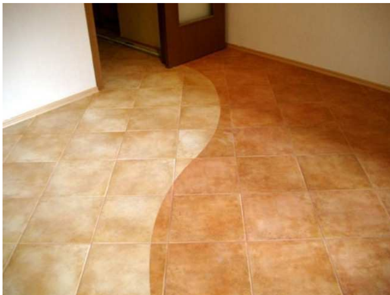
Рис. 70. Полы из керамических плит
