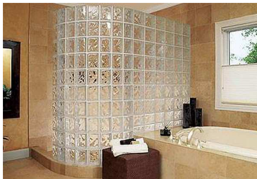
Рис. 49. Перегородка из стеклоблоков
