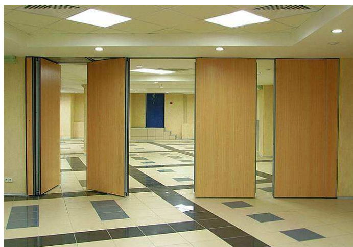
Рис. 56. Внешний вид раздвижной перегородки
