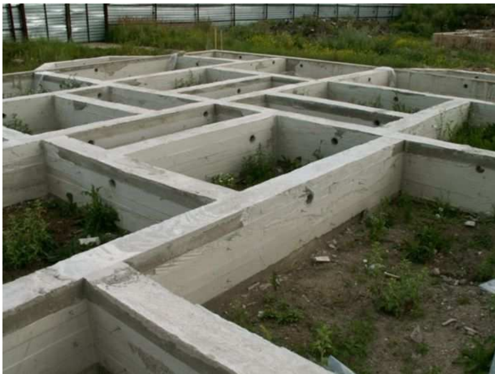
Рис. 13. Пример ленточного фундамента
