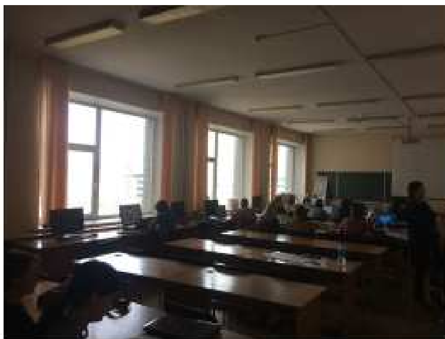
Рис. 63. Вид на светильники в аудитории 1433
