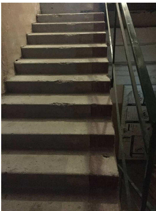
Рис. 149. Лестница на улице Жигура, 68а, г. Владивосток
