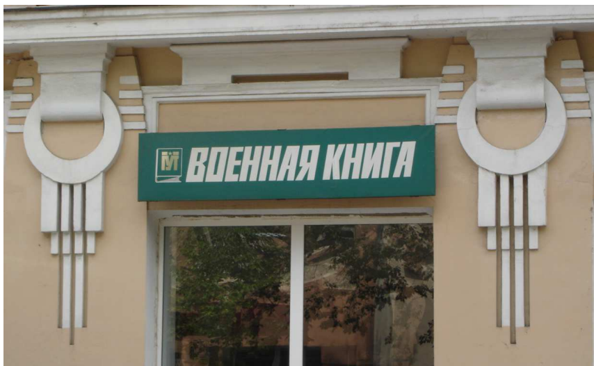
Деталь на здании по улице Светланской 16
